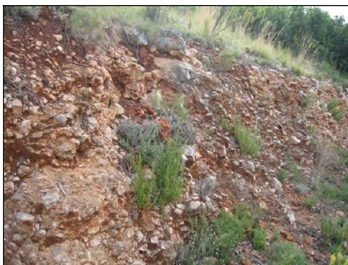
Corte del depósito coluvial.
