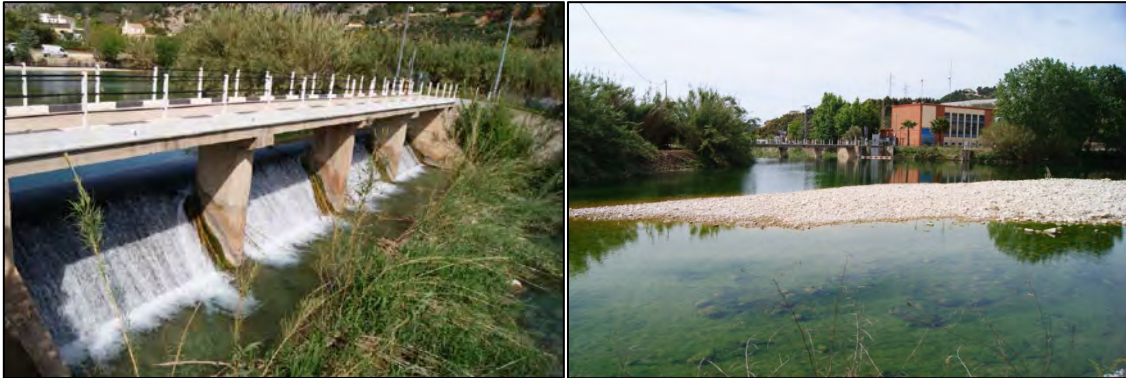
Presa i estació d'impulsió del Consorci
