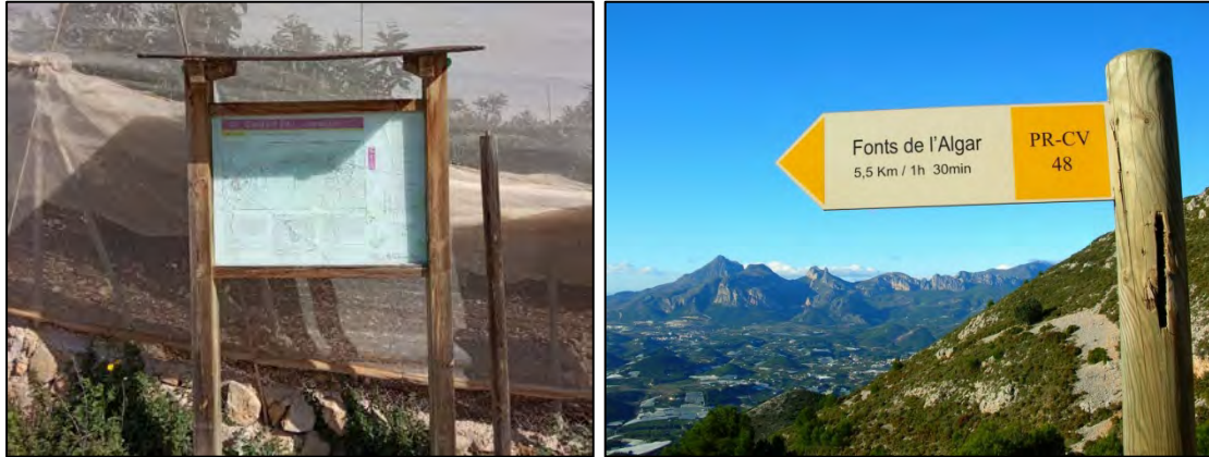
Panell descriptiu i senyalització de la ruta del Camí del Fort en mal estat.
