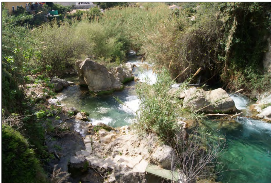
Figura 18. Límit superior del tram T-4. S'observa l'elevada heterogeneïtat que presenta, contribuint a la formació d'una vegetació particular. Al fons s'aprecia la canya com a dominant aigües avall.
