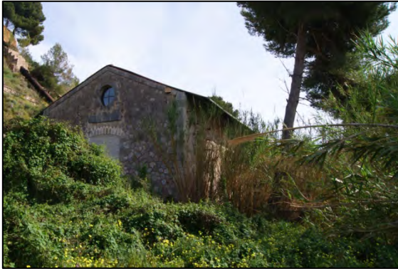
Casa de les Màquines
