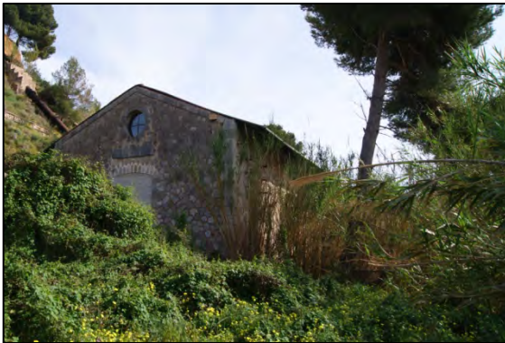
Casa de les Màquines
