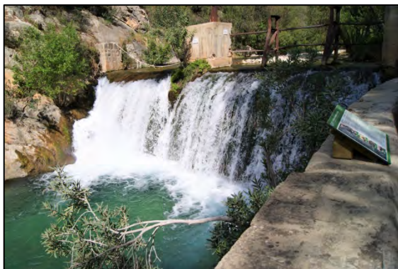
Presa i canal de l'antiga central hidroelèctrica
