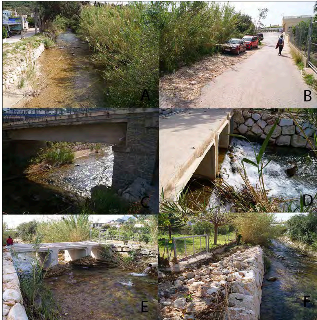
Figura 36. Exemples d'alteracions antròpiques en el tram T-8. A: Edificacions molt pròximes a la zona de ribera. B: Vials d'accés al costat de la zona de ribera i cotxes envaint-la. C, D i E: Ponts. F: Canalització de la gran part del tram.
