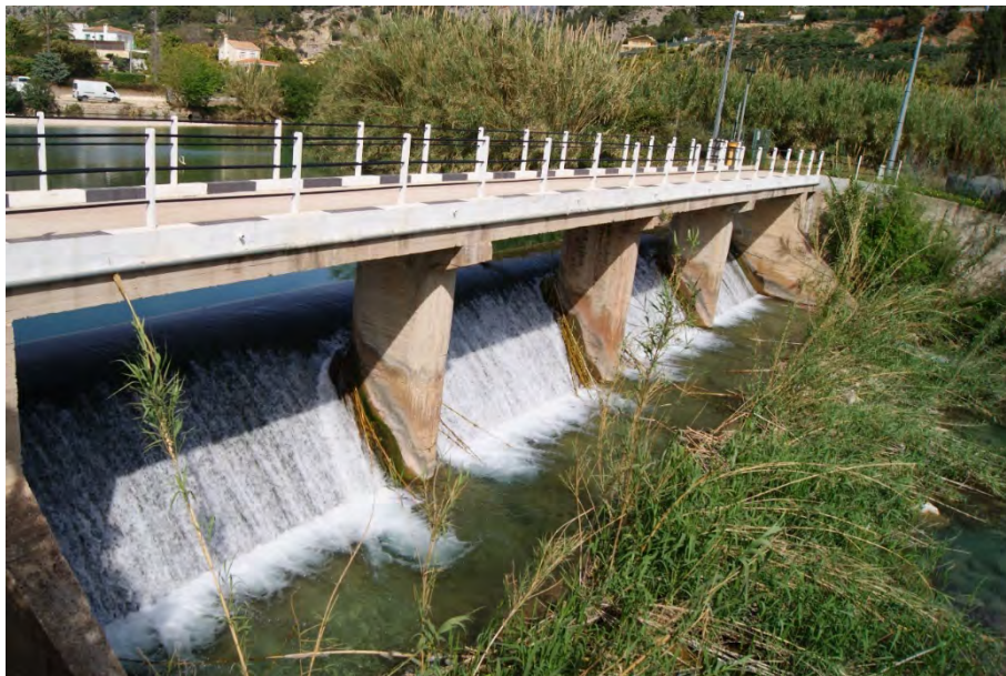
Figura 46. Zona impermeable, que impossibilita del moviment de la fauna aquàtica.
