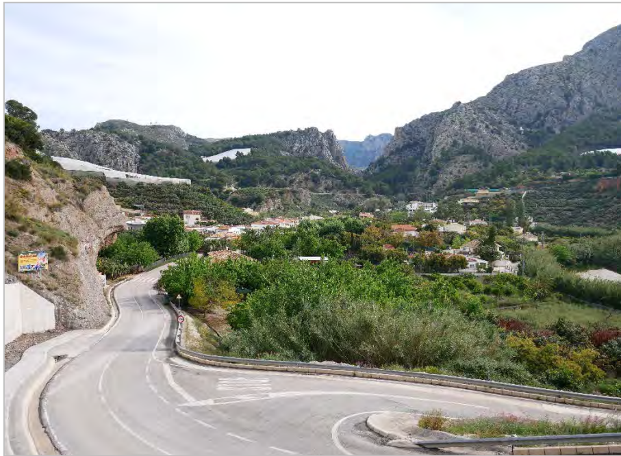
Vista general de la carretera CV-7531 d'accés principal a l'àrea d'estudi.
