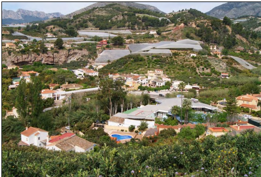
UP5. Vista general àrea urbanitzada
