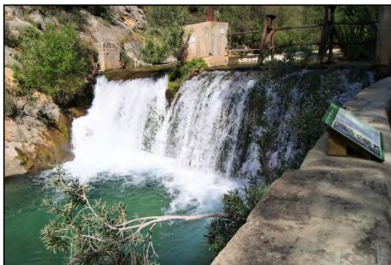
Presa i canal de l'antiga central hidroelèctrica
