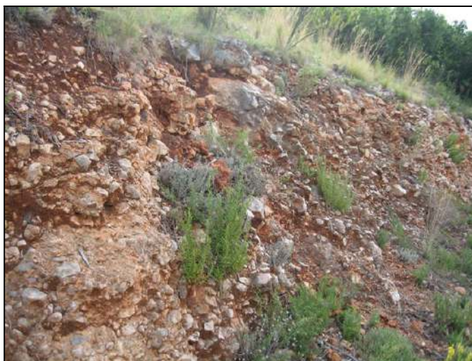
Corte del depósito coluvial.
