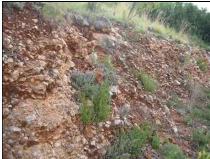
Corte del depósito coluvial.
